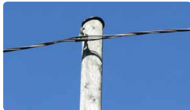
0,4 kV riippukierrejohtojen alapuolella sekä sivulla turvaetäisyys on 0,5 metriä.
